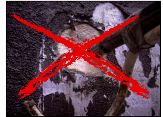
Nicht fachgerechte Einbindung der Gebäudeabdichtung
